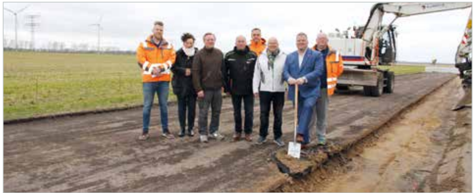
In Meitzendorf erfolgte der erste Spatenstich für den Bau von zwei Bushaltestellen.
