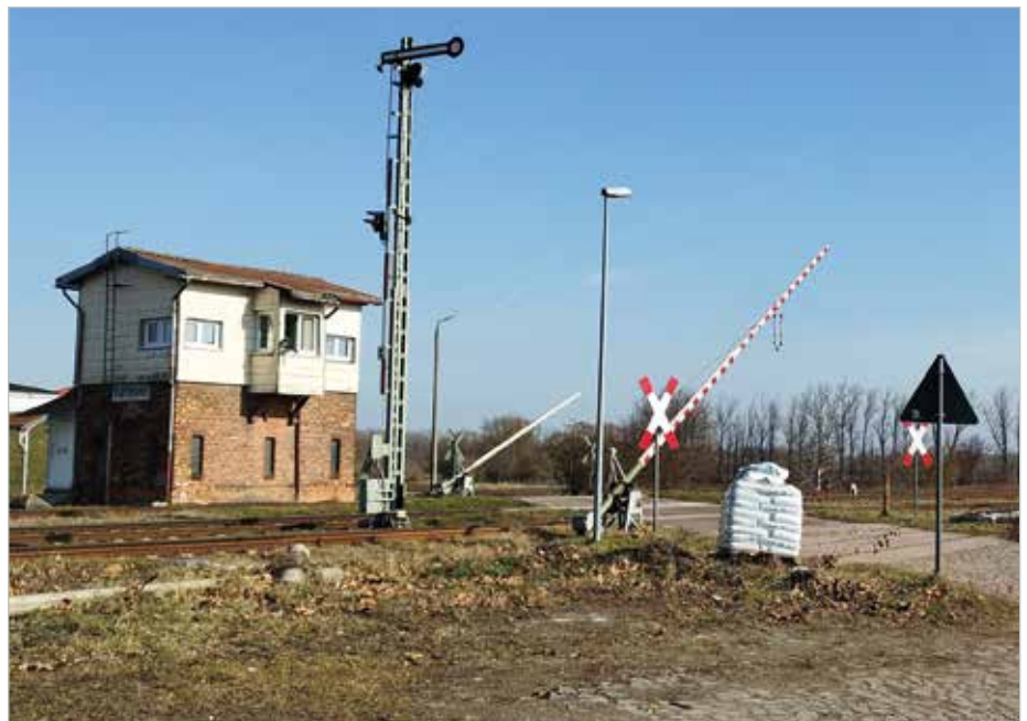
Der Bahnübergang am Buschweg soll geschlossen werden.
