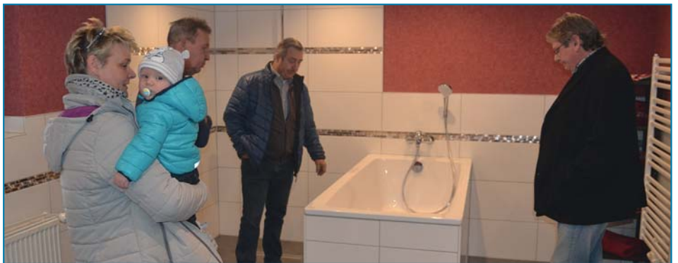
Lokaltermin bei Familie Ferchland, wo der Umbau des Anbaus seinem Ende entgegen geht. Ulrich Dürrmann und Franz-Ulrich Keindorff als Initiatoren der Spendenaktion für Michelle überzeugen sich von den Arbeiten.
