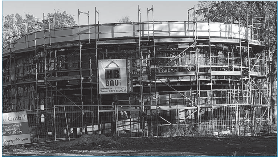
Blick auf die Baustelle der neuen Ebendorfer Kita Ende Oktober.
