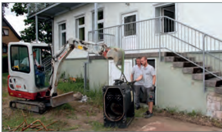
Aus dem Keller wird ein Heizungskessel entfernt. Foto: tz
