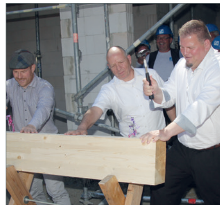
Beim Richtfest auf der Baustelle am Barleber Anger mussten Bürgermeister Frank Nase und FSV-Vize Peter Otte unter den Augen der Zuschauer in brütender Hitze die symbolischen Abschluss-Nägel in einen Balken schlagen. Foto: Ariane Amann
