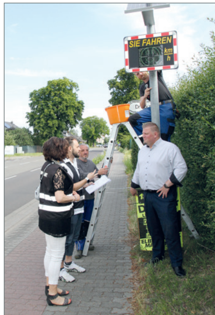
Beim Anbringen der Geschwindigkeitsmesstafel im Breiteweg in Barleben ließ sich Bürgermeister Frank Nase (re.) von Dennis La Terra (2.v.l.) über deren Funktionsweise informieren. Das Gerät kommt ohne zusätzlichen Strom aus. Ein Solarpanel erzeugt die nötige Energie. Foto: Zschke
