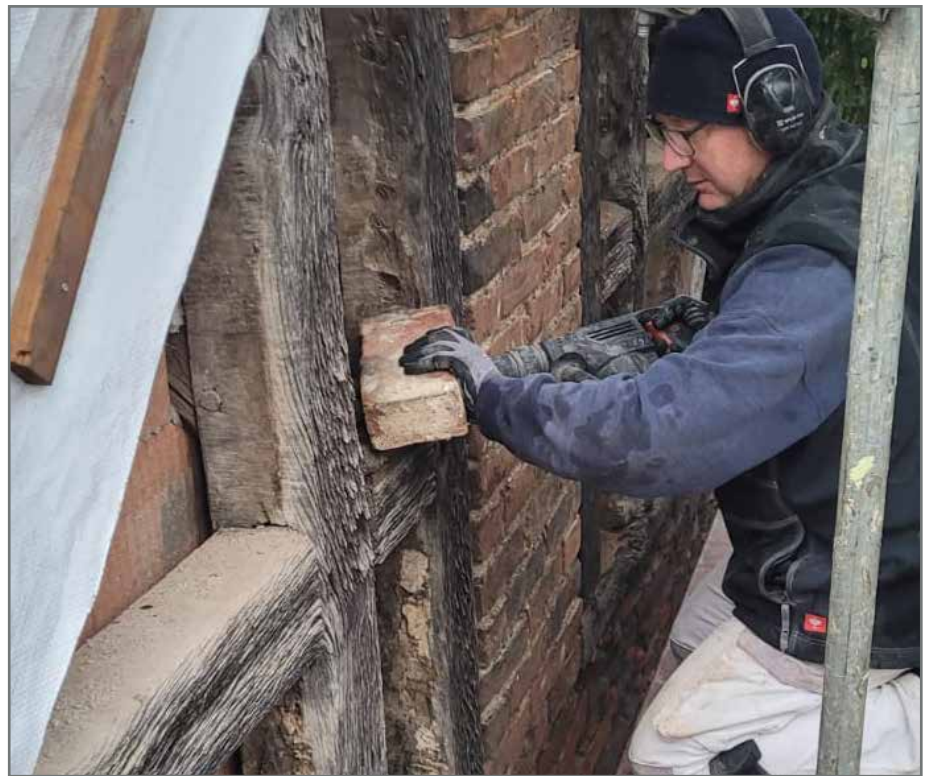
Die Fassadensanierung an der Barleber Kirche St. Peter und Paul ist in vollem Gange, die Kirchengemeinde sucht noch Paten zur Unterstützung. Foto: Ute Lüder
