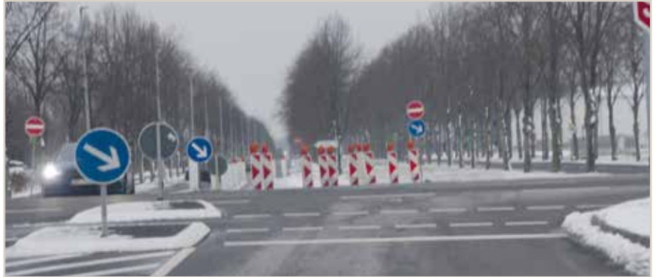
An der Otto-von-Gericke-Allee ist eine zweite Richtungsfahrbahn entstanden, die Bauarbeiten sind jetzt abgeschlossen. Foto: Ariane Amann
