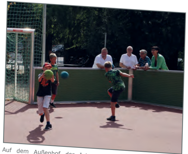
Auf dem Außenhof der Internationalen Grundschule "Pierre Trudeau" in Barleben ist über die Sommerferien ein 10 mal 15 Meter großer Soccer-Court (ein eingezäunter Fußballplatz) entstanden. Die Ecole-Stiftung hat dort investiert, um den Hof den Bedürfnissen der Kinder anzupassen und die Staubbelastung durch den vorherigen Bodenbelag zu reduzieren. Angenommen wird der Court hervorragend, die zahlreichen Soft-Fußbälle sind dort in jeder Pause und nach dem Unterricht in Aktion. „Durch die Bande haben auch Kinder Spaß und Erfolgserlebnisse, die sonst nicht viel Fußball spielen“, freut sich Schulleiterin Anke Strehlow. Foto: Ariane Amann
