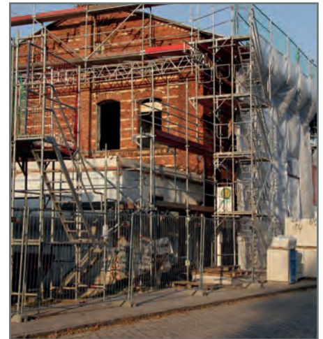
Baustelle altes Bahnhofsgebäude in Barleben. Deutlich erkennbar sind die historischen Rundbögen an den Fensteröffnungen, die erhalten bleiben sollen. Foto: A.Amann
